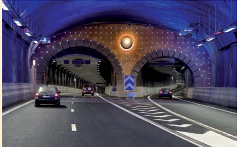
Fig. 2 Túnel SondraLanke en Estocolmo, Suecia.
