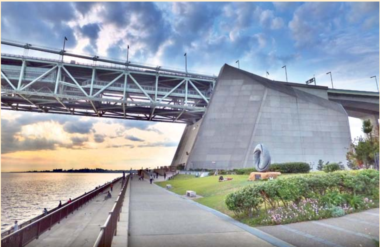
Fig. 1 Estribo del puente Akashi-Kaikyo (Pearl Bridge) en Kobe, Japón.
