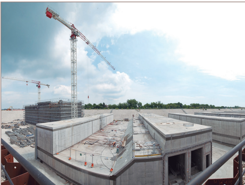
➤ Estructura en concreto reforzado que sirve de soporte y cajón de las compuertas. FLICKR - VETTO
