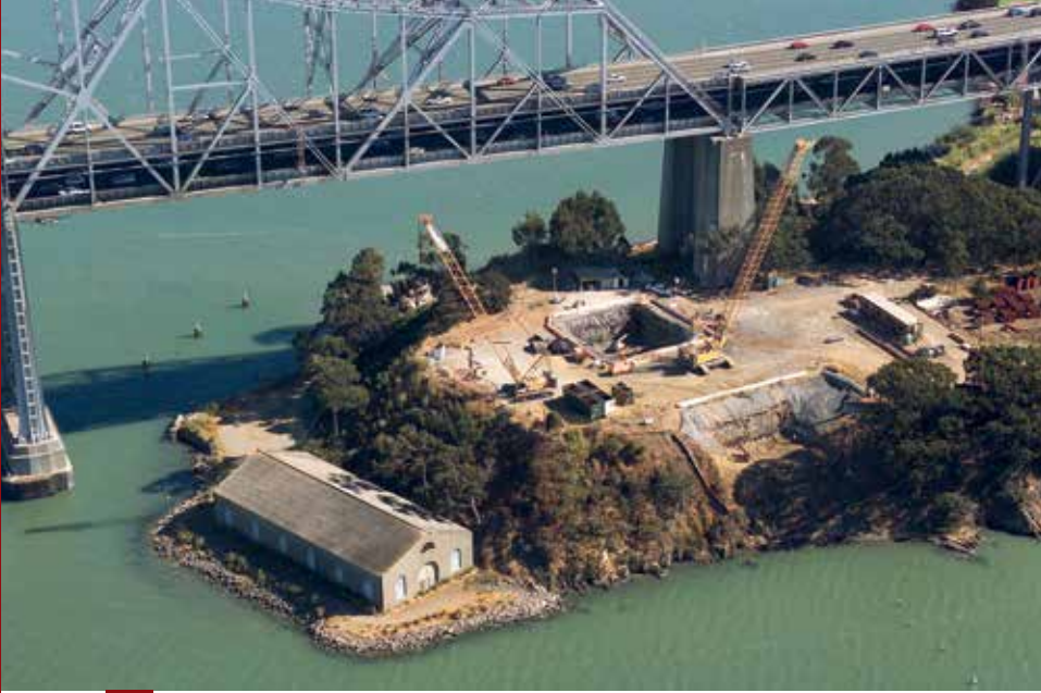
Construcción de la cimentación del nuevo puente que une a San Francisco con la Bahía de Oakland, en Estados Unidos.
