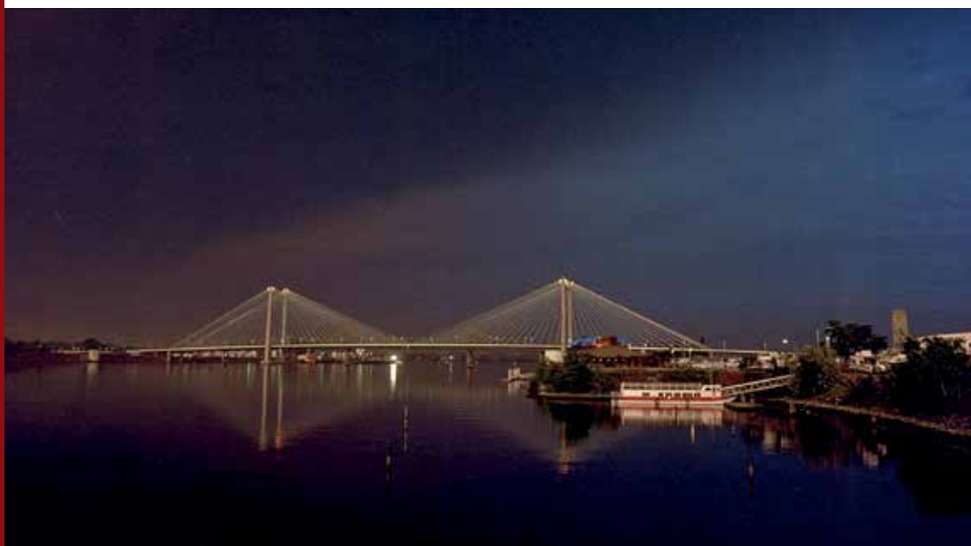
Puente PascoKennewick en Estados Unidos.
