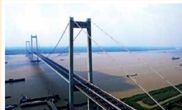
Vista del Puente de Taizhou en Jiangsu, China.
