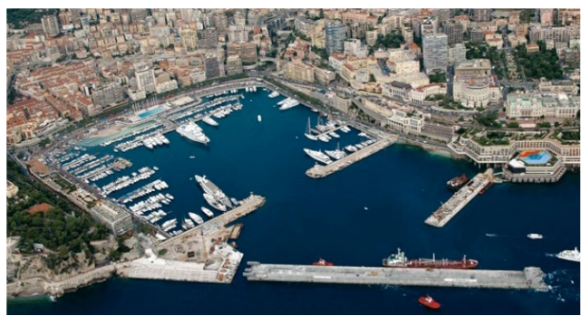
Dique flotante de concreto en Mónaco.
