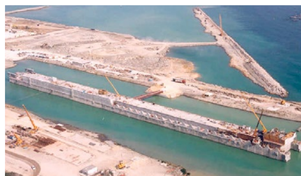
Proceso de construcción del dique.
