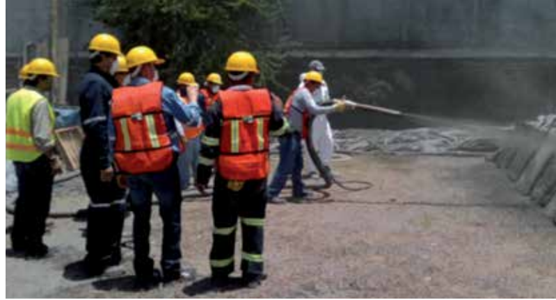
Lanzado del concreto vía húmeda posición vertical.
