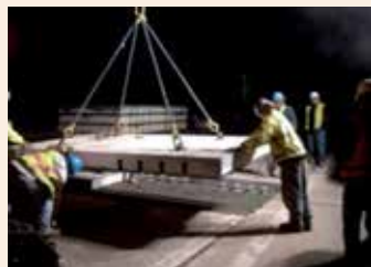
Pavimentos prefabricados, (Cortesía Dr. Shiraz Tayabji, Enero 2012).
