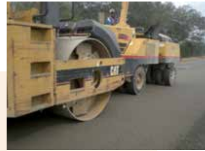
Pavimentos de concreto compactado con rodillos, CCR, Tuxpan, México 2013.
