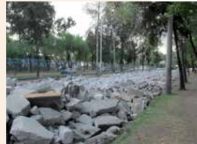
Concretos reciclados, México, D.F. 2013.
