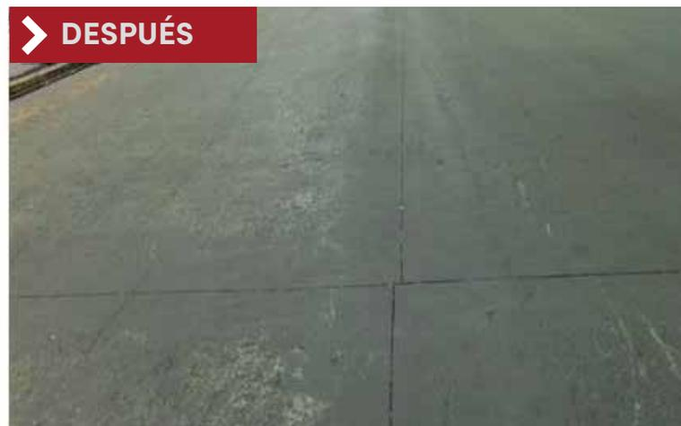
1. Para problemas de oquedades en el suelo del terreno natural o en la sub base, se accederá desde la superficie de la losa de concreto aplicando mezclas químicas para estabilizar la sección del suelo dañado y así mismo levantar la placa de concreto hasta llegar a su nivel original o de diseño.
