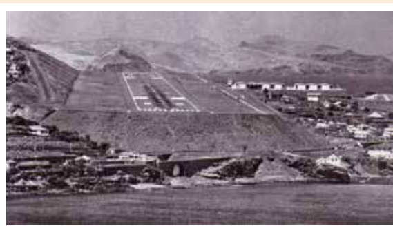
Aeropuerto original de Madeira.
