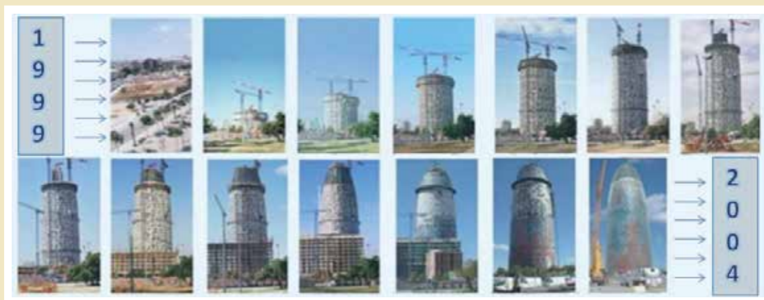
Secuencia de construcción de la Torre Agbar.
