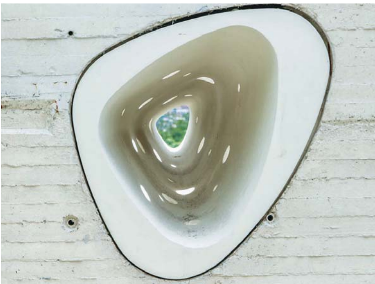
Detalle de los elementos de la fachada occidental.
