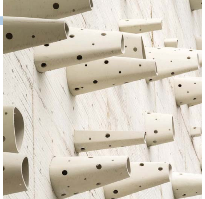
Elemento prefabricado de GRC, de la fachada occidental.
