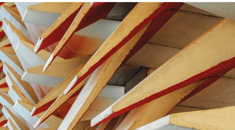
➤ Elemento prefabricado de concreto de alta resistencia, de la fachada oriental.
