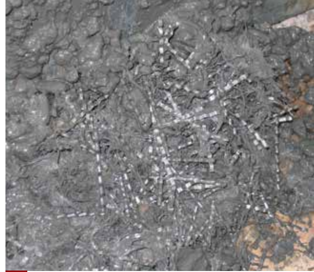
Incorporación de las fibras en el concreto.
