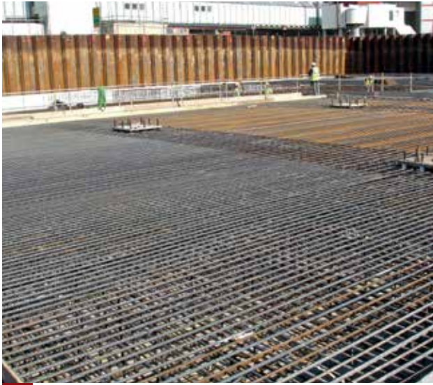
Ejemplo de gran densidad de armado.
