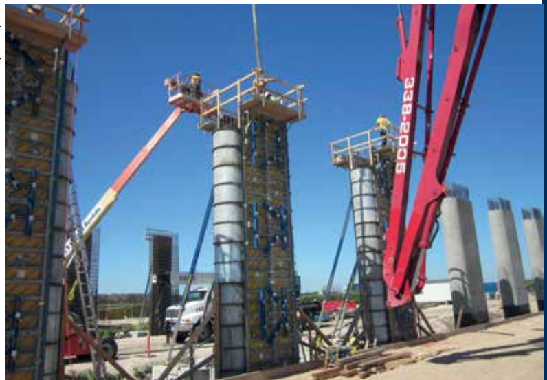
Vaciado de las columnas de CentrePort Canada Way.
