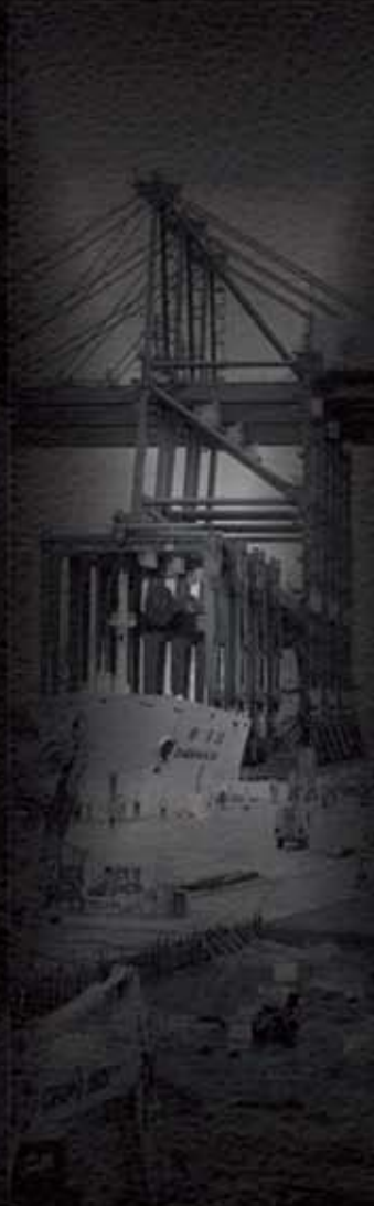
obra marítima y excavación profunda
