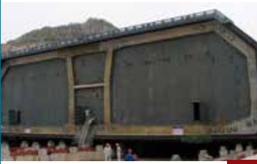
Sección prefabricada del túnel sumergido que compone el proyecto HZMB.
