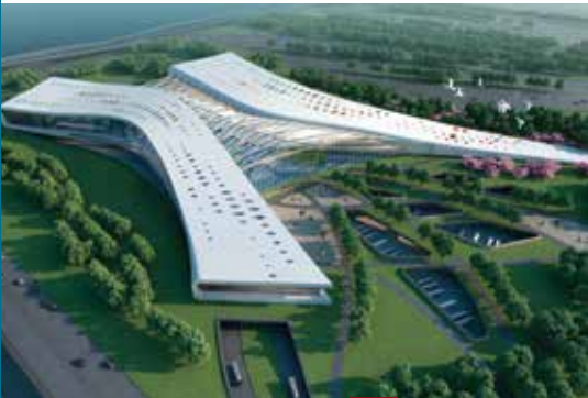
Isla artificial para el empalme entre el puente y el túnel. Proyecto HZMB.
