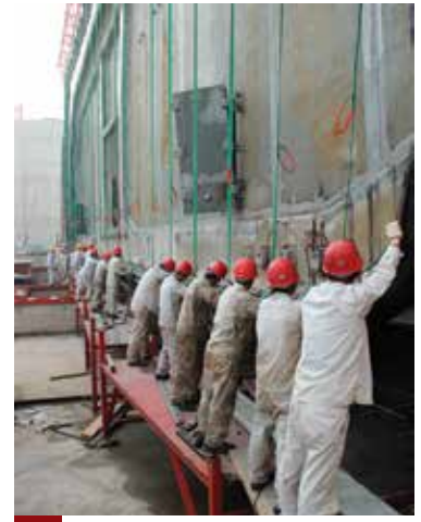
Una vez que una sección de túnel se conecta a los tramos existentes, los muros de partición son removidos.
