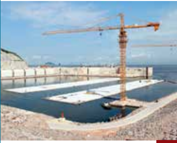
Fabricación de los segmentos prefabricados del túnel sumergido que hace parte del proyecto HZMB.
