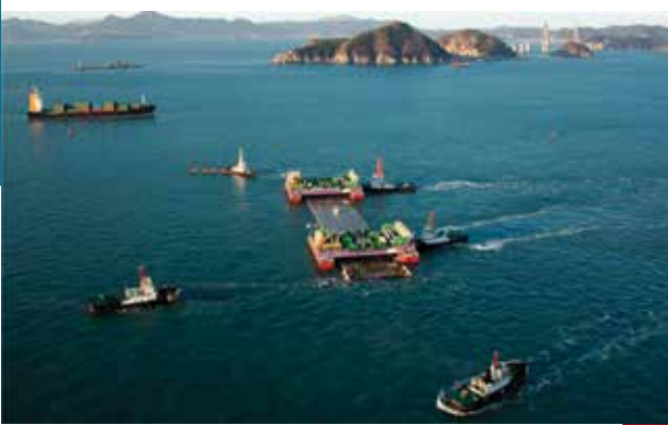
Transporte de los elementos del túnel sumergido Busan Geoje, en Corea del Sur.
