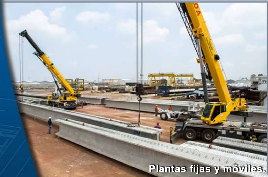
Parque Toreo 140,000m 2 de estructura prefabricada de concreto. Columnas de hasta 39m de longitud
