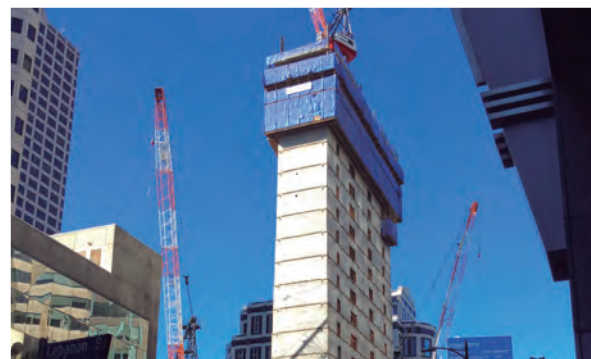
Proceso de construcción del núcleo de la Wilshire Grand Tower (Diciembre del 2014).
