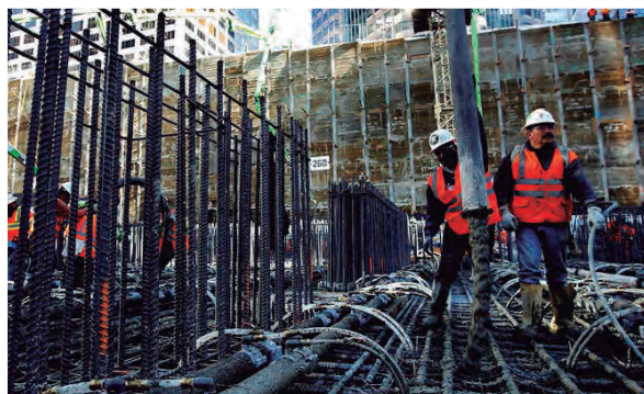
Sistema de enfriamiento en el vertido de concreto de la cimentación.
