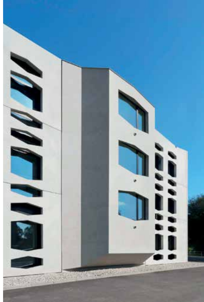
Edificio con prefabricados.
