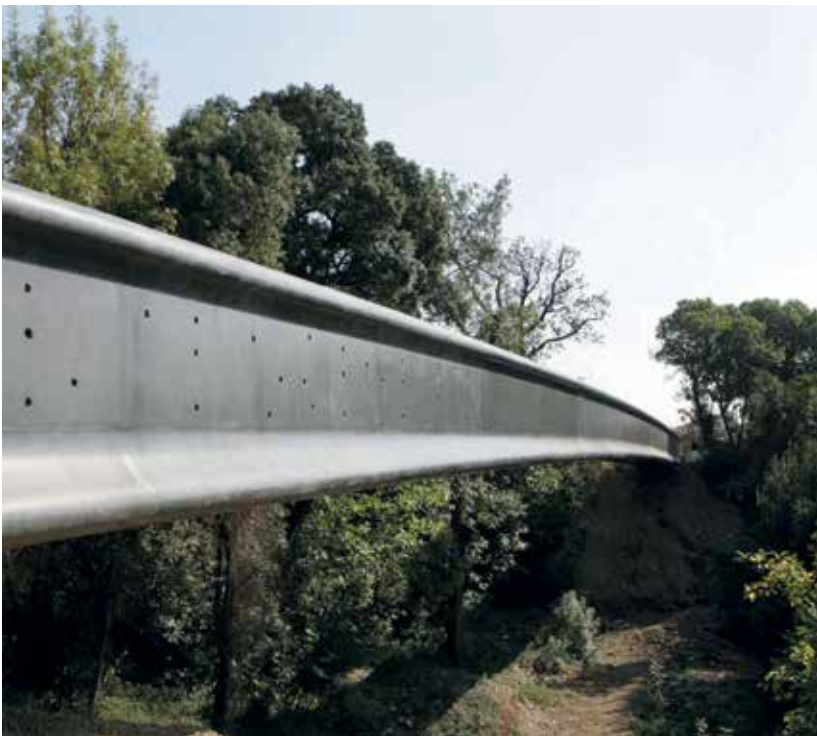
Pasarela "Pont du Diable", diseñada por el arquitecto Rudy Ricciotti y el ingeniero Romain Ricciotti. 70 metros de longitud de concreto de muy altas prestaciones reforzado con fibra (UHPFRC).
