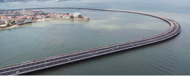
► Puente marino vehicular. Cortesía: Odebrecht Infraestructura América Latina.
