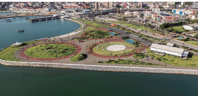
➤ Relleno de empalme del puente marino hacia Cinta Costera II. Cortesía: Odebrecht Infraestructura América Latina.
