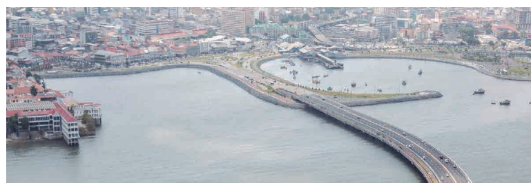
➤ Relleno del mirador del Pacífico. Cortesía: Odebrecht Infraestructura América Latina.
