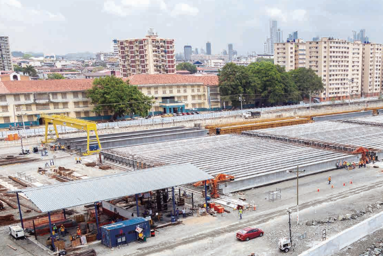
► Patio de prefabricados de concreto. Cortesía: Odebrecht Infraestructura América Latina.
