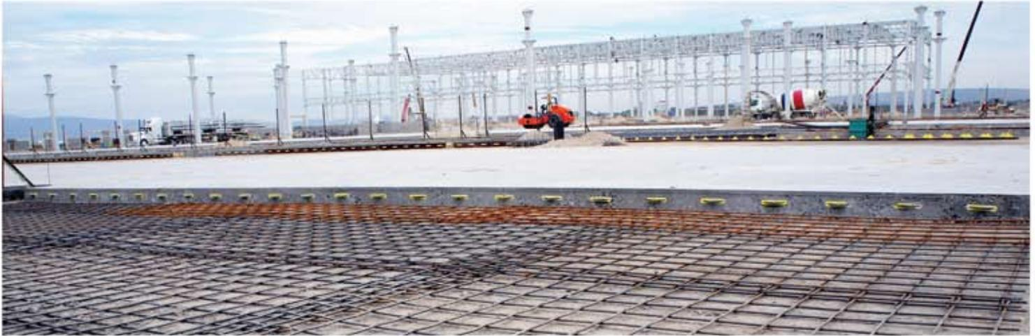
La Malla de Ingeniería es un armado electrosoldado para refuerzo de concreto que sustituye en forma eficiente a los armados de varilla de 3/8" hasta 3/4".
