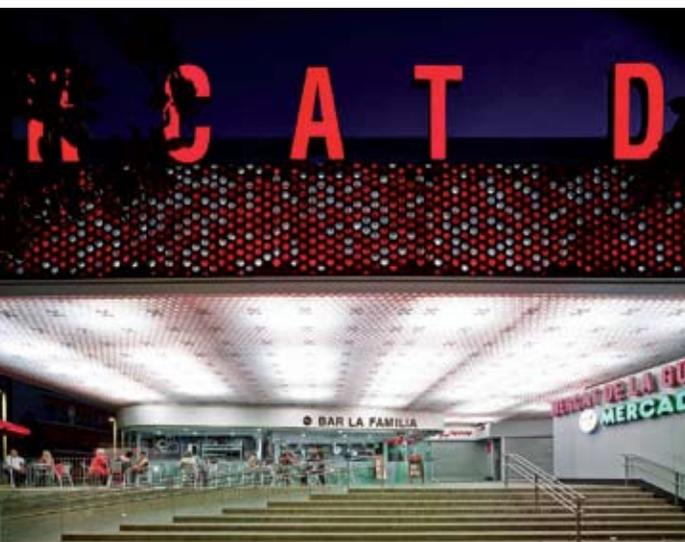
de Barcelona, significó la ampliación de una crujía en todo su perímetro creando una nueva fachada. Esta se resuelve con una celosía de 152 paneles de concreto UHPC (Ultra High Performance Concrete") de dimensión 2.80 x 2.30 metros, con perfiles trenzados hexagonales de 3 x 7 centímetros de espesor, totalmente calados con orificios circulares de 15 cm. de diámetro. Los paneles incorporan unos discos de policarbonato en rojo translucido, rojo opaco y transparentes alojados en
