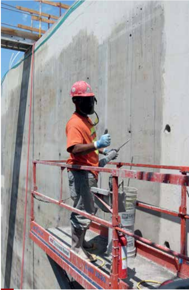
Aplicación de impermeabilizantes sobre la superficie de concreto.
