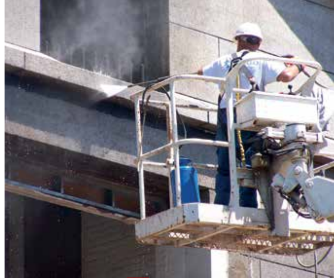
Limpieza con rociado con agua a alta presión
