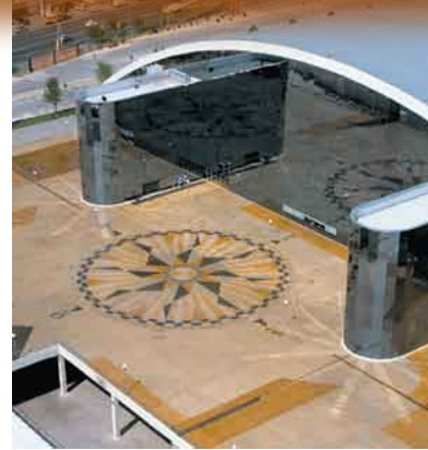
FOTO: CORTESIA KAMIRO
