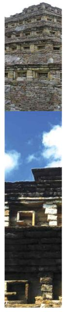
ministración y debido a su peso no se aplicó en las losas. Sin embargo, para resolver el problema, los ingenieros totonacas emplearon un agregado ligero de piedra pómez de un tamaño máximo de 10 cm, que les permitió obtener un concreto de 1050 a 1100 kg/m³, lo suficientemente ligero como para la construcción de pisos superiores y techos planos.
