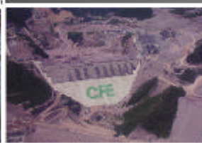
Presa "El Cajón", Nayarit
