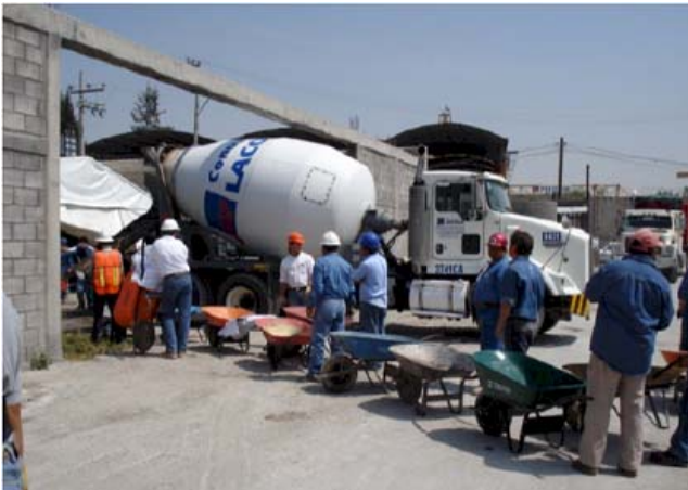
CONCRETO 01/2008 y 05/2008 Zona Centro (Estado de México)
