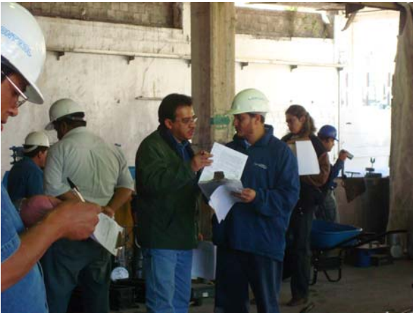
CONCRETO 01/2007 Zona Centro (D.F)
