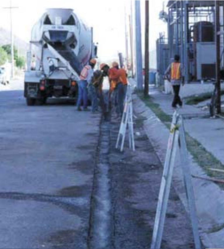
Relleno en zanjas para gas natural, Hermosillo, Sonora
