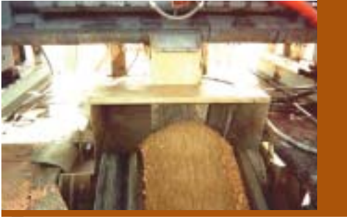
La pasta aguada creada por una máquina Hydromix es alimentada en un camión Westroc.
