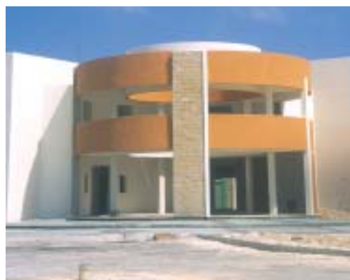
La Sede de Seguridad y Tránsito utilizó entre cimentación, estructura, albanilería y exteriores 663.29 m 3 de concreto de diversas resistencias
