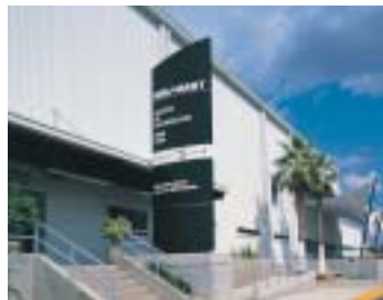
Centro de Distribución Wal Mart Ing. Raúl Ancona Riestra, Ing. Carlos Ancona Riestra e Ing. Alonso Vargas Zanoquera
