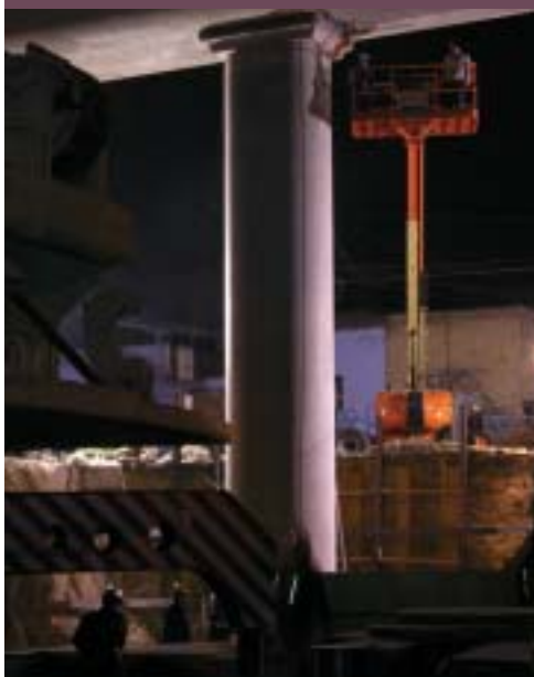
Colocación de la marcas de referencia topográfica en el fuste de la columna
