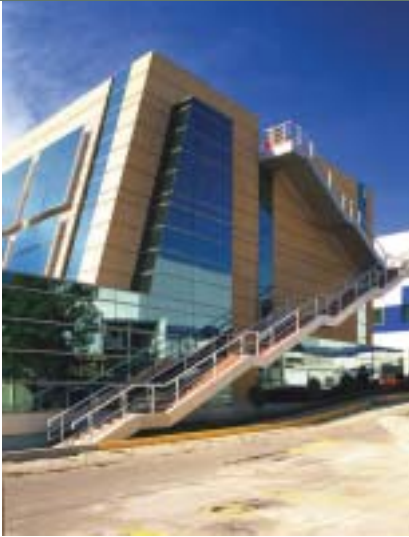
Bristol Myers Squibb / Migdal Arquitectos, México, D.F.
