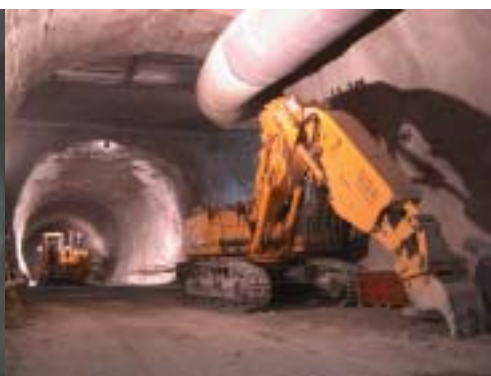
Escudo de perforación, nótese la escala humana en el ángulo inferior derecho construcción del túnel convencional.
