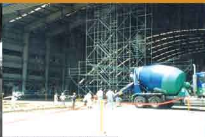
Plataforma para Hangar
