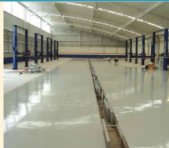
se recomienda el uso de recubrimientos superficiales epóxicos (EUPOXY TUFCOAT, EUPOXY TUFCOAT DBS, EUPOXY TUFCOAT HB+ o DURALKOTE 240) o recubrimiento de uretano de alto desempeño (EUCOTHANE).
