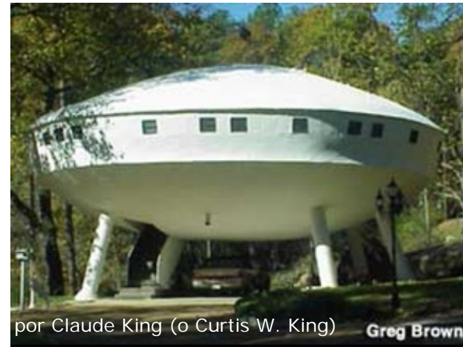
Estructura de concreto
